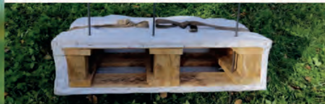
Instalação de abrigos para os peixes (Lunkers)
